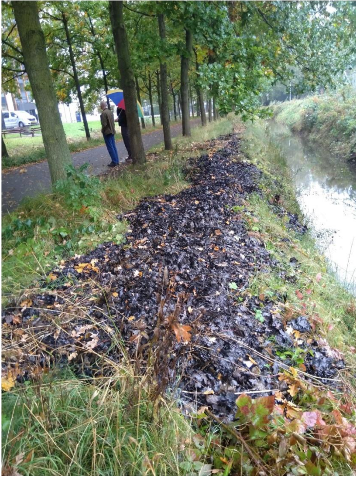
Figuur 17. Materiaal uit de sloot op de kant gezet.
